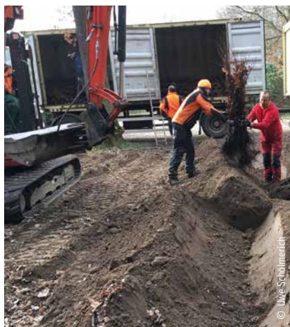
Bild 35: Pflanzeneinschlag mit dem Kleinbagger
