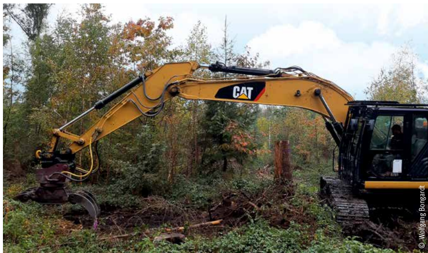
Bild 28: Freiräumen von Pflanzplätzen mit dem Bagger von der Rückegasse aus
